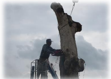
【クレーンで木の上部をつり上げてチェーンソーでの作業】
