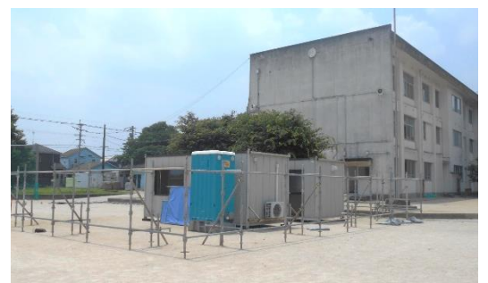
仮設事務所設置中
